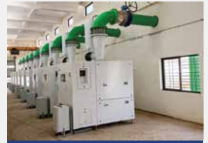
100 MLD Vinzol WWTP Project
